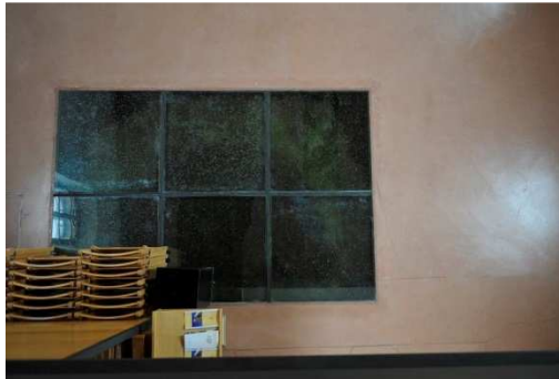
Slika 23: Pogled na od vlage zamegljene steklene plošče pod katerimi je prezentirana arheološka dediščina v cerkvi sv. Duha (Foto: F. Aš, Arhiv: ZVKDS, OE Novo mesto).
