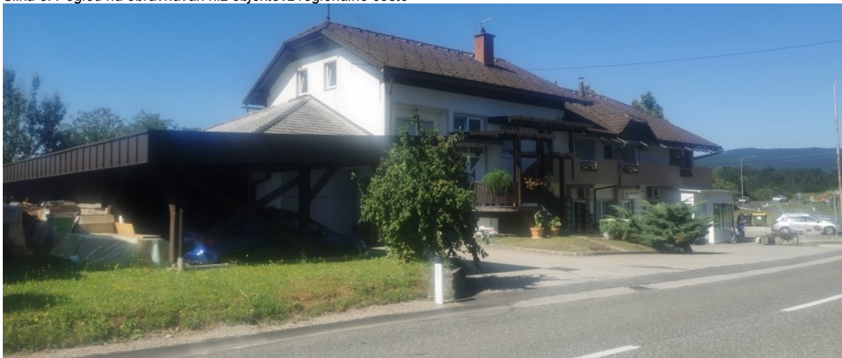
Slika 3: Pogled na obravnavan niz objektov regionalne ceste
