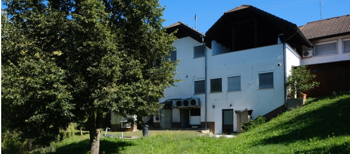
Slika 4: Pogled na obravnavan niz objektov z južne strani, kjer je prisotna kombinacija dvokapnih streh na prizidkih objekta in predlagan dodatni prizidani del za potrebe dejavnosti
